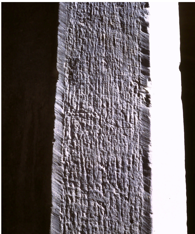
Fig. 9: Aosta, Chiostro della Cattedrale. Dettaglio in luce radente di una colonna poligonale. Si nota la lavorazione della superficie piana con uno scalpello piatto, e la rifinitura degli spigoli con uno scalpello più piccolo. Al centro, un cerchio con inserito un fiore a sei petali: una delle rare marche lapidarie presenti nel complesso del chiostro.
