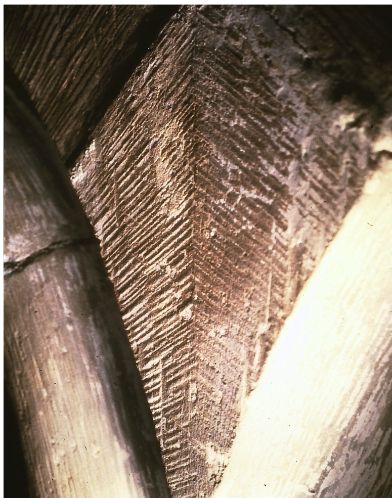
Laie , o Laye , o Marteau taillant . Qui sotto, le tracce lasciate da questo strumento sulla pietra. (Losanna, Cattedrale, attorno al 1230, luce radente).
