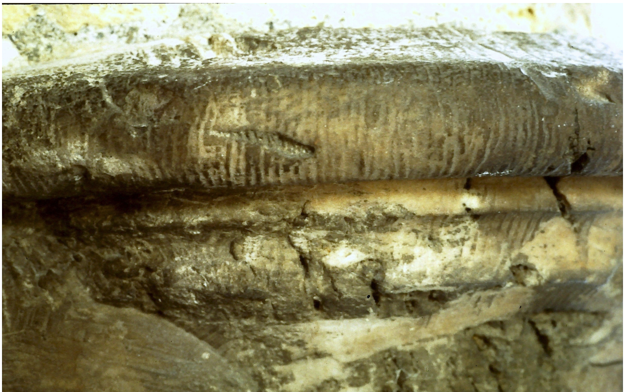
Aosta, chiostro della Cattedrale. Tracce lasciate dalla ' brettue ' a cinque denti nella modanatura di un toro.
