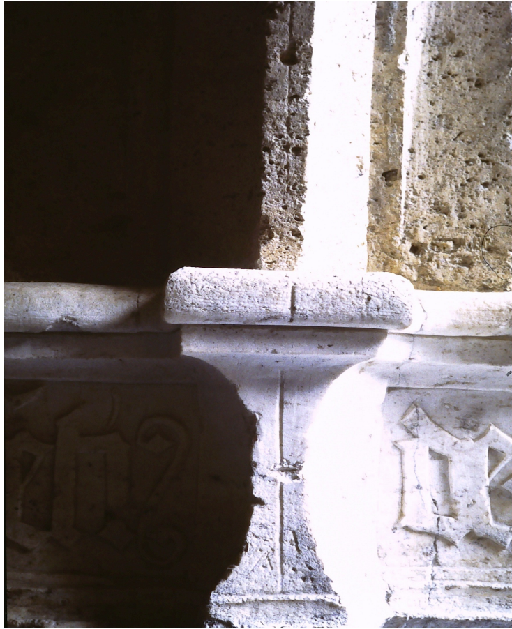
Fig. 6: Aosta, Chiostro della Cattedrale. Segni di allineamento su capitello ed arco.
