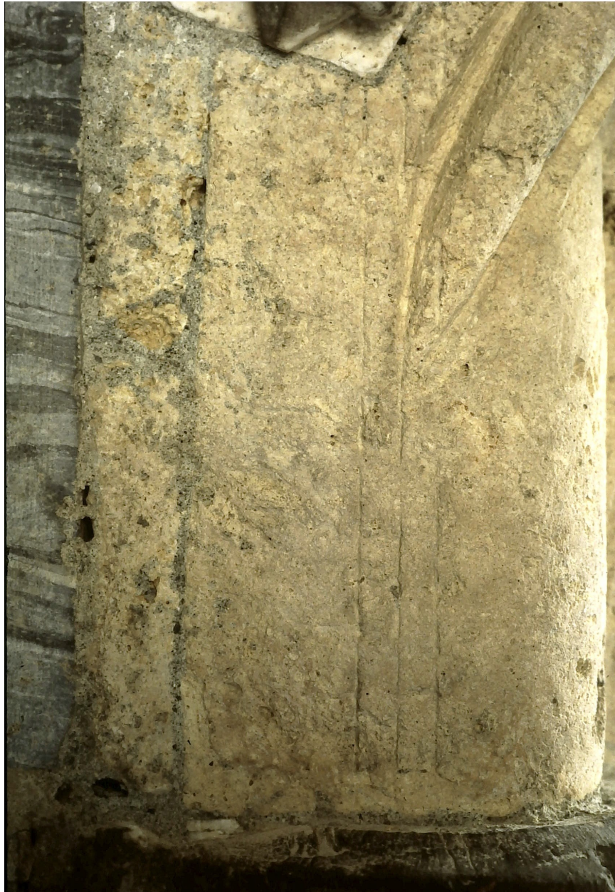
Fig. 8: Aosta, Chiostro della Cattedrale. Contrafforte centrale Nord, arco Ovest. Segni di allineamento fra la base dell'arco e la sottostante colonna. Sulla sinistra è evidente uno spessore riportato per rispettare il registro desiderato.
