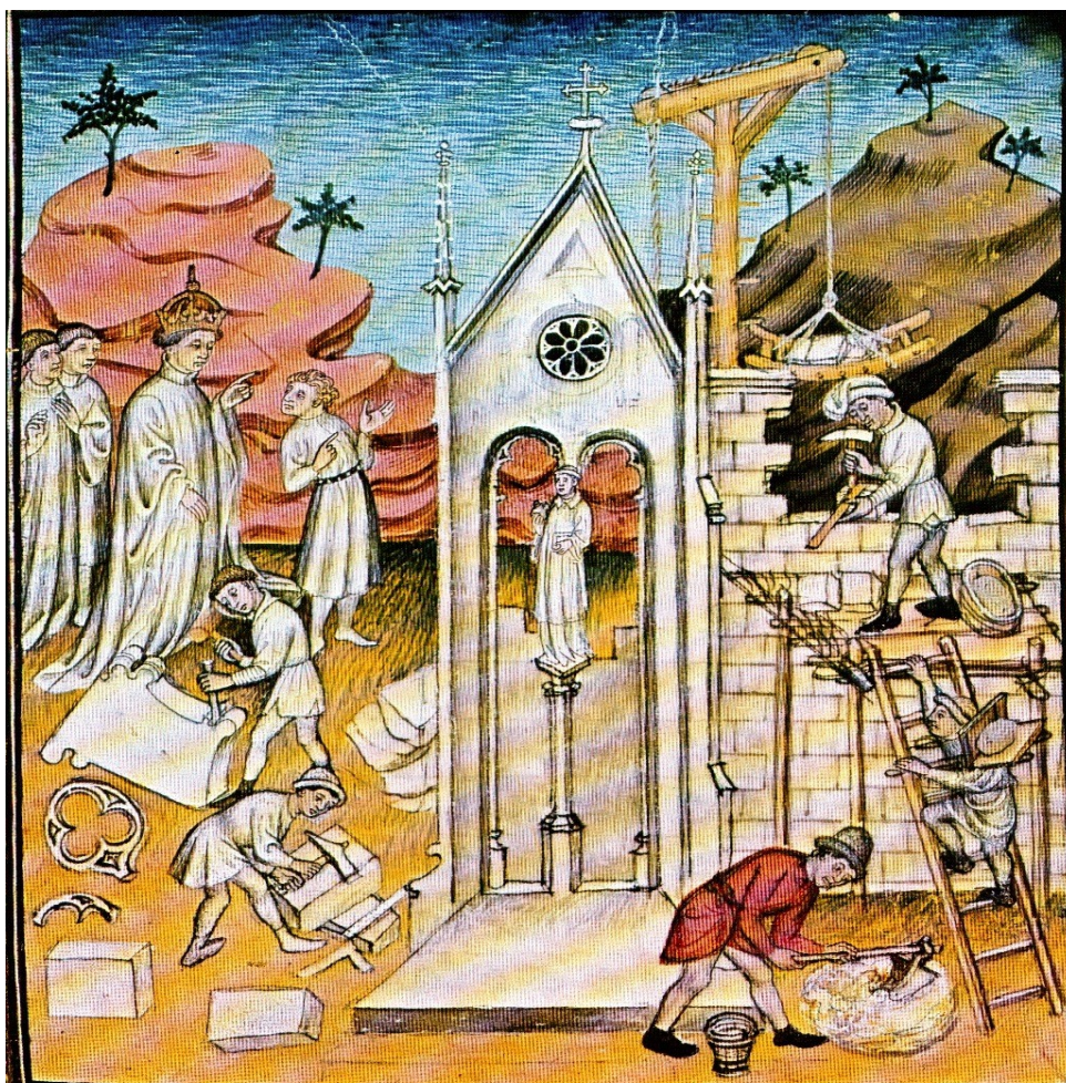
Fig.2: Altra rappresentazione di un cantiere ( Grandes Chroniques de Saint-Denis , XIV° secolo). A distanza di due secoli dall'immagine precedente, il cantiere viene rappresentato in maniera del tutto analoga. Si nota però la comparsa di sistemi a pulegge per il sollevamento dei carichi, ed il Magister che illustra il lavoro al committente coronato.
