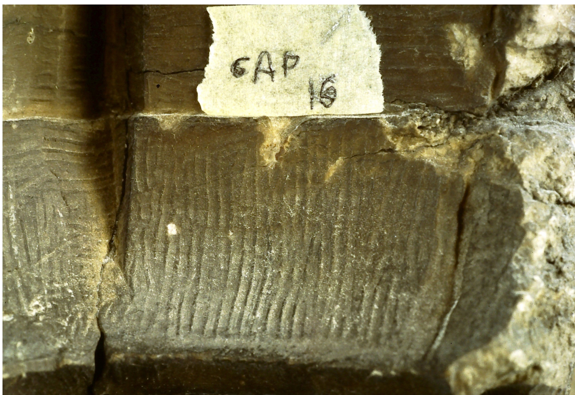
Fig. 10: Aosta, Chiostro della Cattedrale. Dettaglio delle tracce di una raspa a denti quadri usata per rifinire un capitello in gesso cristallino.
