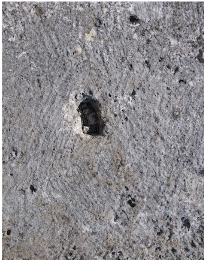
Martello 'a pettine', per pietre dure. Qui sotto, le tracce lasciate da questo strumento sulla pietra.
